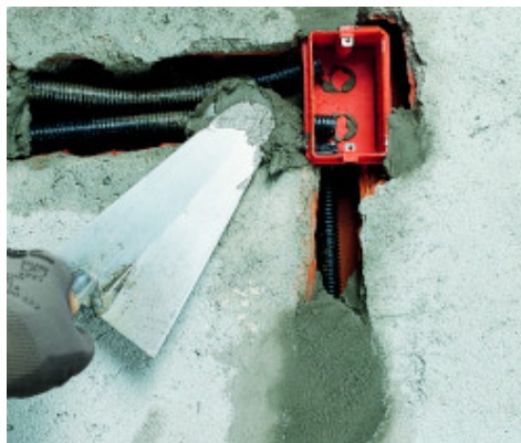
Montage von Elektroinstallationen mit Lampocem
