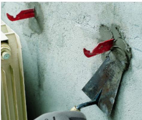
Montage von Heizungshalterungen mit Lampocem
